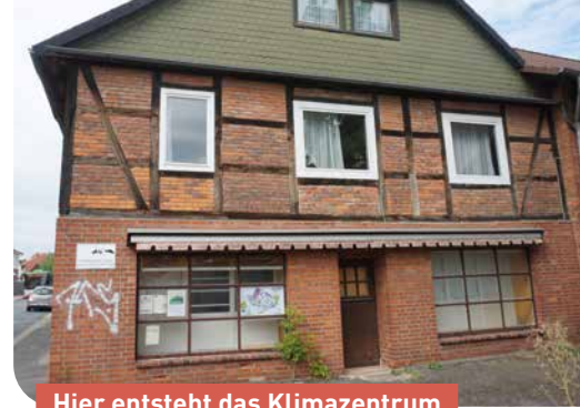
Hier entsteht das Klimazentrum
